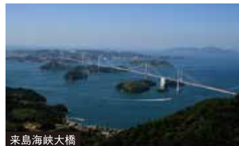
来島海峡大橋
